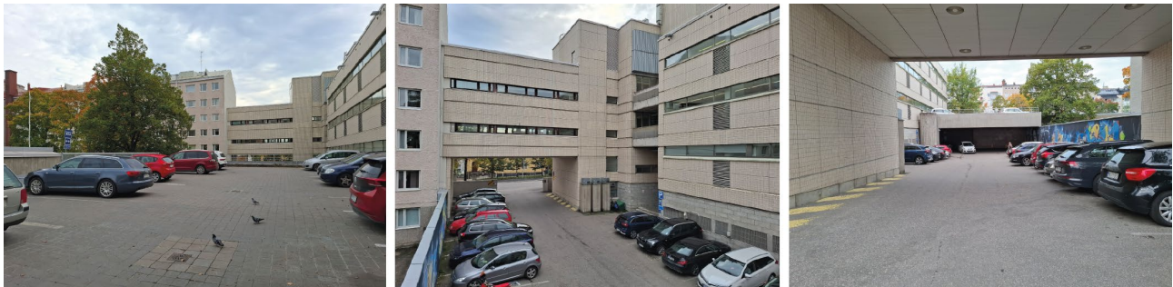
Kuvia suunnittelualueen pysäköintialueista, vasemmalla ylempi pysäköintitaso ja keskellä sekä oikealla alempi taso (9/2024)
